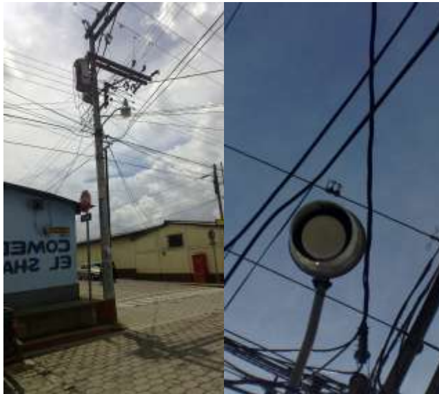
Fuente: 5ta calle de la zona 1, municipio de La Esperanza, Departamento de Quetzaltenango, se observa Luminaria tipo canasta modificada con lámpara Led.
