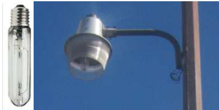
Figura No. 33 Lámpara de sodio Tubular colocada en una luminaria tipo canasta.
