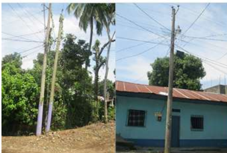
Figura No. 43 Soportes de concreto y soportes de madera.
