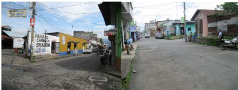
Fuente: 3era. Avenida entre 8va. y 9na. calle zona 1, B. Independencia. 2da avenida entre 2da. Y 3ra. Calle zona 2, B. Rosario.
