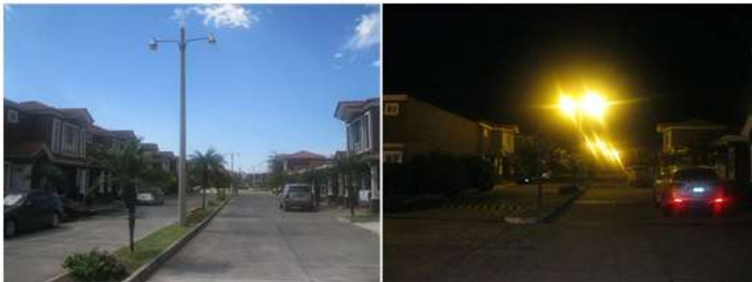
Figura No. 35 Tipo de luminarias colocadas en vías de cuatro carriles.
