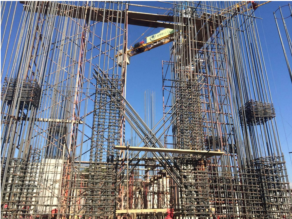
Figura 3 Armado de muros de cortante con viga de acople. Fuente: archivo fotográfico personal.
