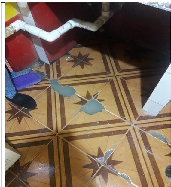
Pisos en mal estado: esto ha provocado resbalones y caídas, por derrames en el piso y porque no ha reparado pisos agrietados.
