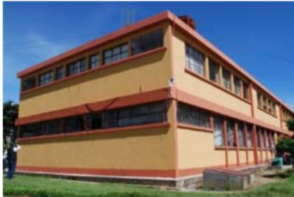
Figura 4. Daño estructural, efecto columna corta. Terremoto San Marcos 2012
