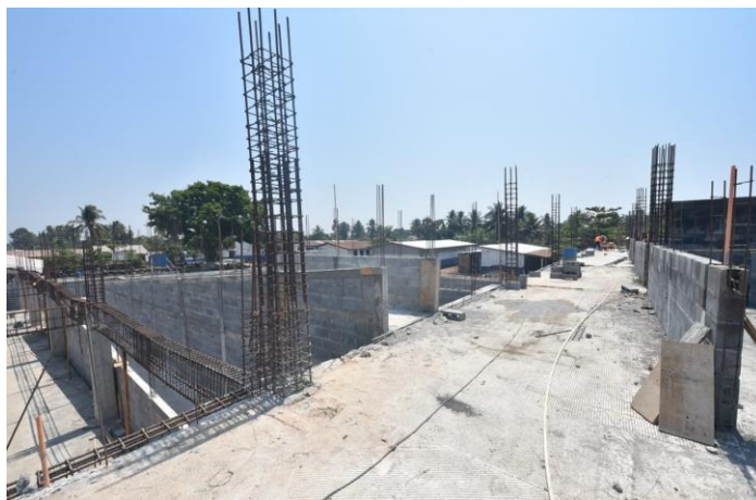
Figura 5. Proceso constructivo Escuela Sipacate, Escuintla.
