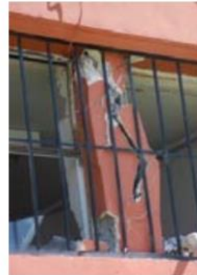
Figura 4. Daño estructural, efecto columna corta. Terremoto San Marcos 2012
