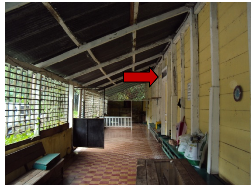
4 HABITACIONES EN EL AREA DE BODEGA (Por habilitarse)
