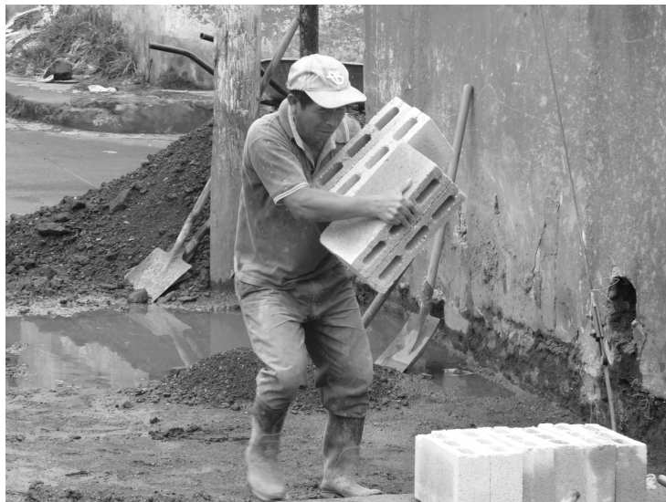
Foto No. 5: Obrero de la construcción en sus labores. Fuente: El Autor
